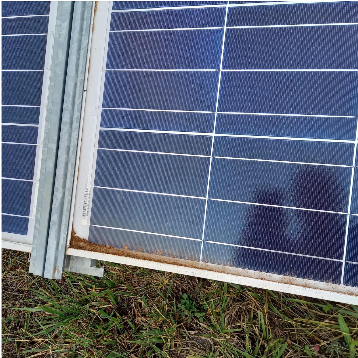
85. ábra: A napelem alsó sarkában és élében felhalmozódott szennyezőanyag.
