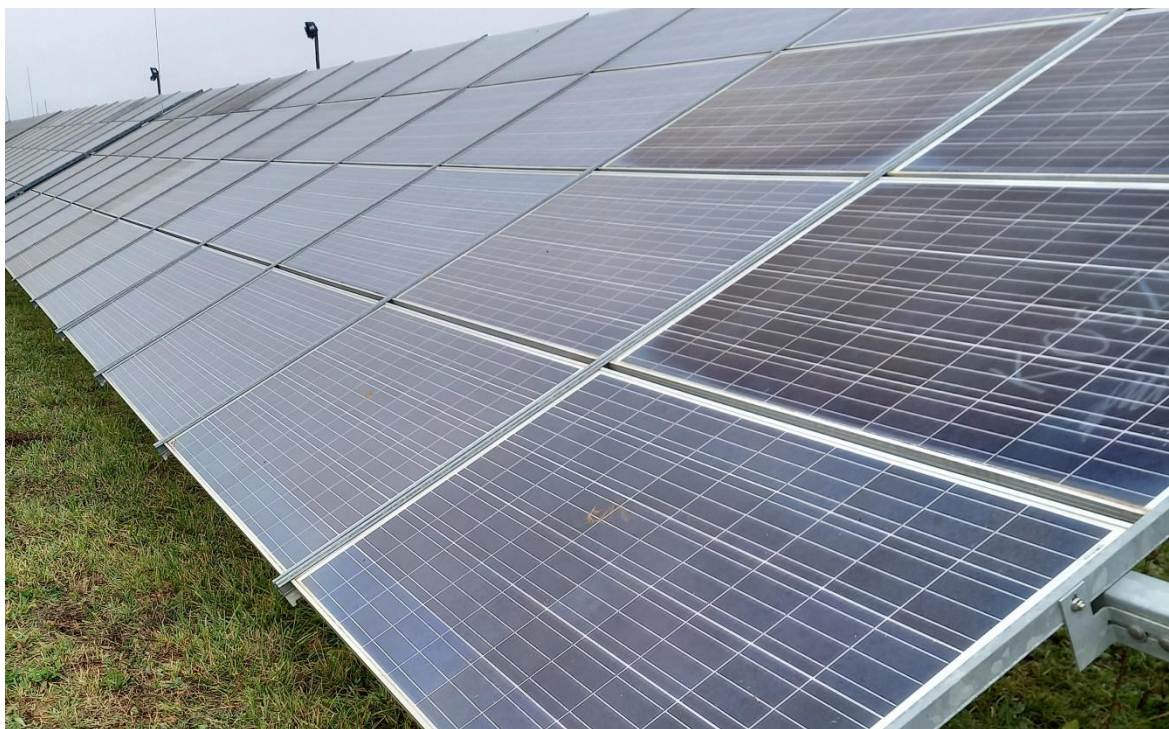
83. ábra: Mikroméretű (szállópor) típusú egyenletes porlerakódás a napelem felületén.
