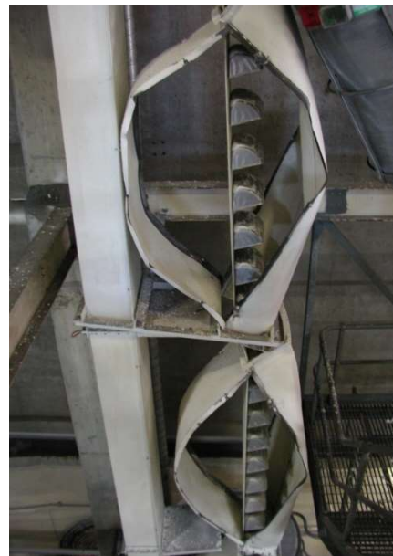
1.2. ábra Lefúvós védelemmel el nem látott serleges elevátor robbanást követően
