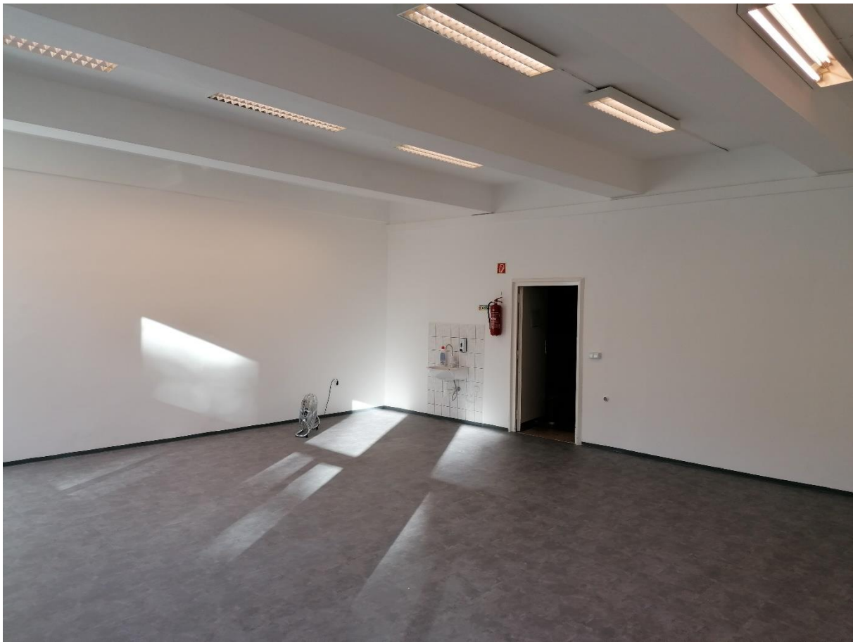
10. ábra: Az építészeti munkák befejezte utáni állapot.
