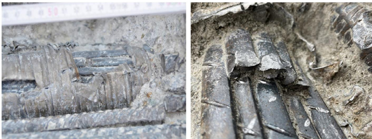
10. ábra. Remanens mágnesességgel észlelt feszítőhuzal törések [3].
