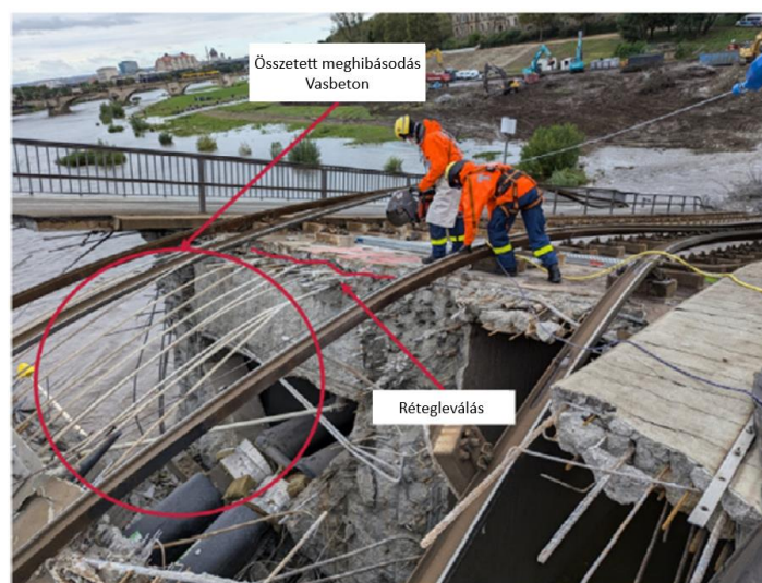
3. ábra. Törési keresztmetszet kihúzódott vasalással [3].
