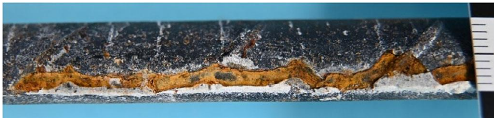
6. ábra. Feszítőhuzal különösen markáns repedésképződéssel [3].
